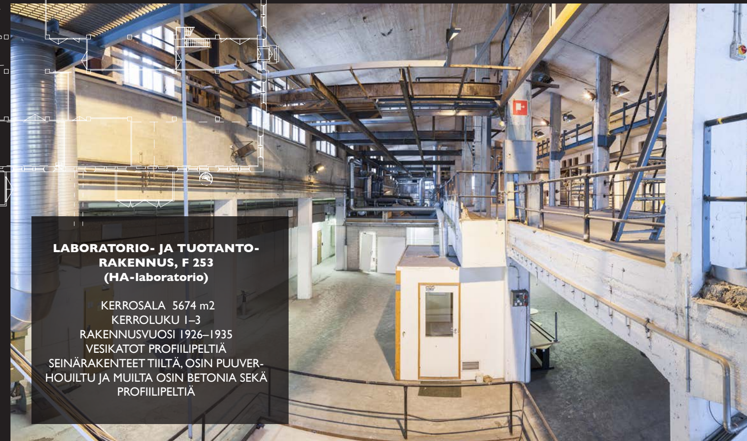
LABORATORIO- JA TUOTANTORAKENNUS, F 253 (HA-laboratorio)
